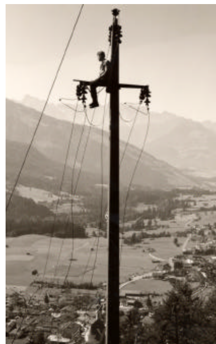
Montage von Stromleitungen, 1965
